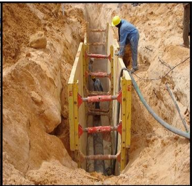
Figure V-3-Soutènement par blindage
