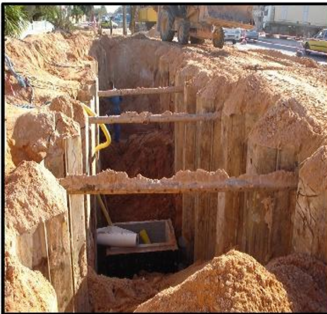
Figure V-2- Soutènement en palplanche
