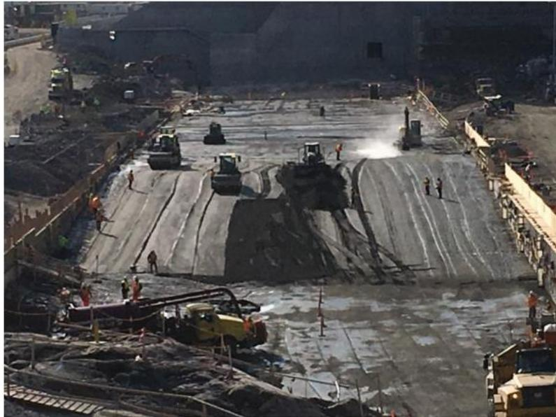
**Figure I.5 :** Mise en place du BCR en 10 couches inclinées de 300 mm pour construire une levée de 3 m au barrage de Muskat Falls, Canada
