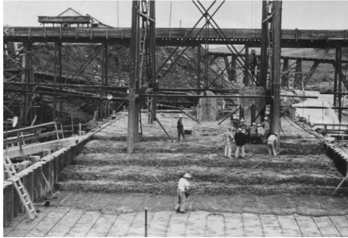
**Figure I.4 :** Mise en place de couches de béton de masse dans un seul plot du barrage
