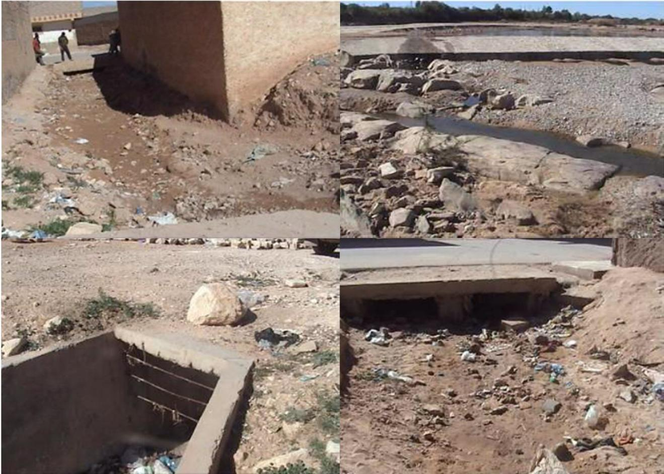
Fig.III.13:Galerie en mauvaise états qui véhiculé les eaux de ruissellement de (S/B5)
