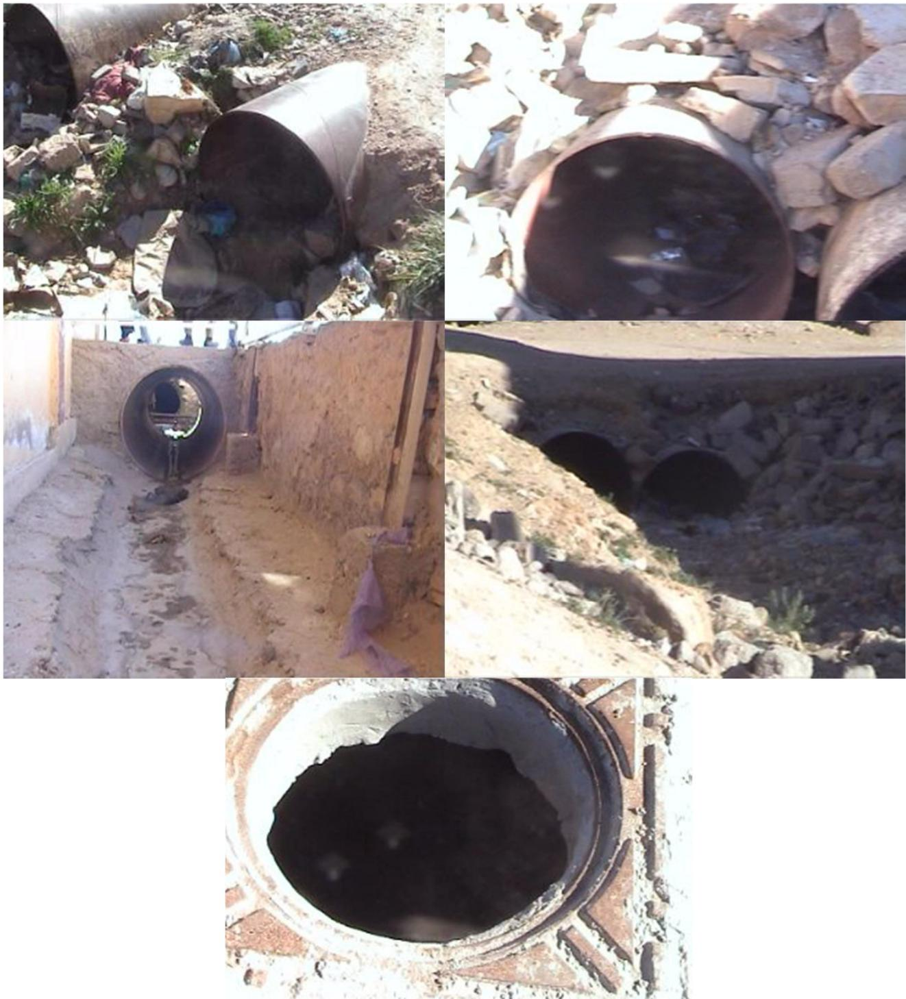
Fig.III.12: L'aménagement existant qui véhicule les eaux de ruissellement dans (S/B3)
