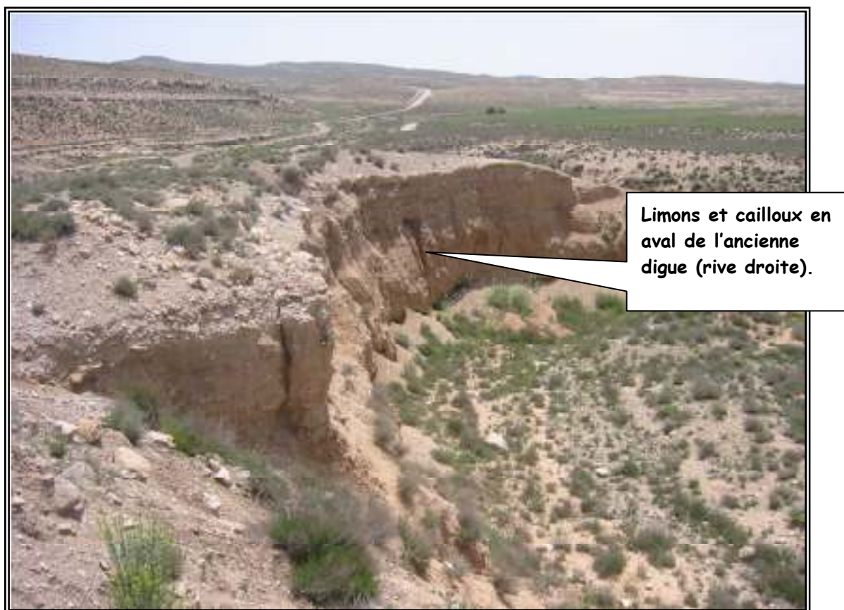
Figure II.04 : la zone d'emprise de la future digue
