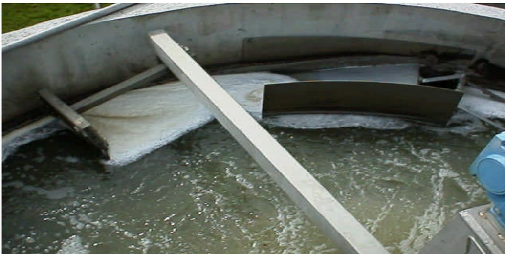
Figure N° II -3: Racleur des graisses d'un dessableur- dégraisseur.
