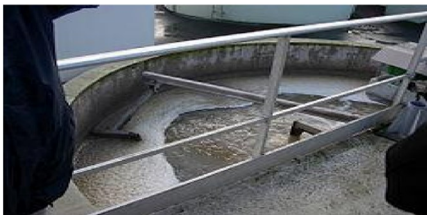
Figure N°11 : Déshuilage par écumage des graisses.
