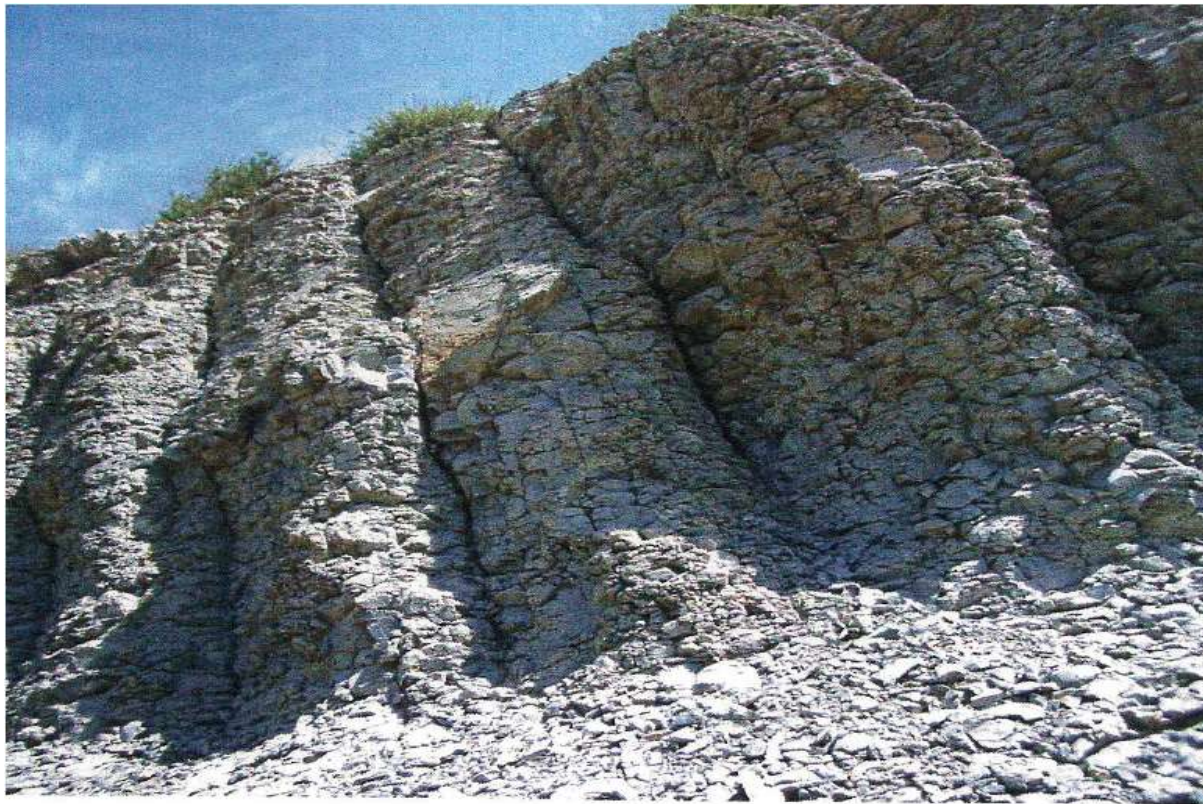
Photo 5 : Appui rive gauche, alternance des joints fermés et ouverts
