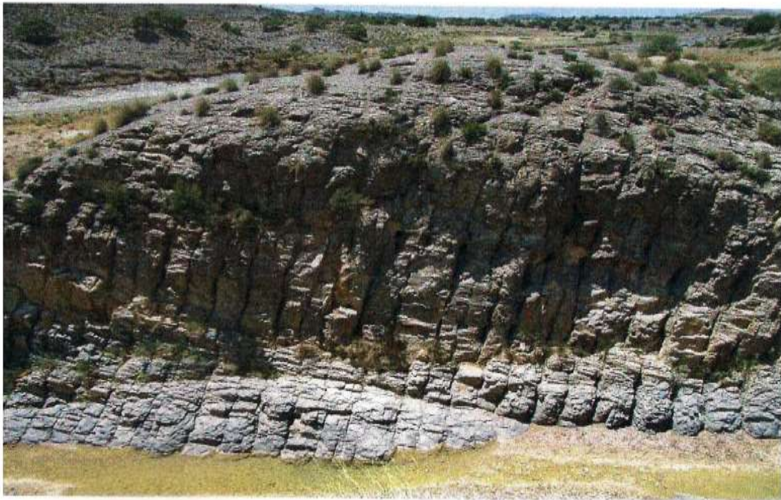
Photo 5 : Appui rive gauche, alternance des joints fermés et ouverts
