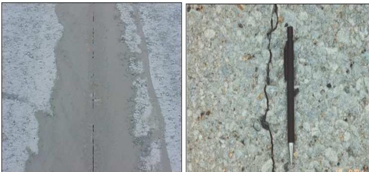
*Figure VI. Fissures au niveau des joints*
