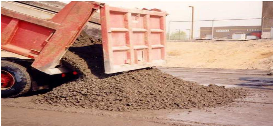
*Figure VI.1 Aspect typique d'un BCR pour barrage*
