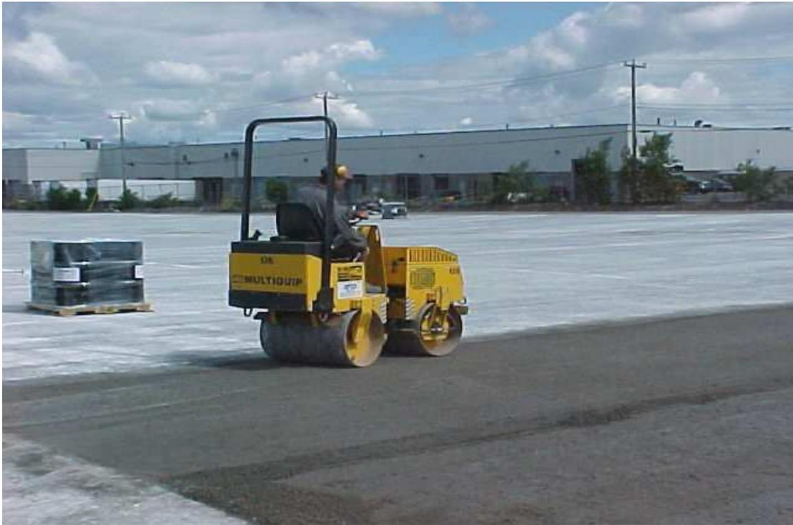
*Figure VI.6 photographie d'un petit rouleau compacteur pour la finition.*
