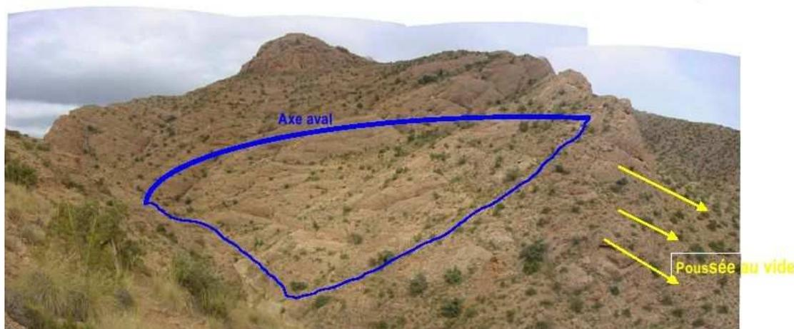
Figure IV-3 : Problématique de l'axe aval du barrage voûte, Source [ANBT] Echelle 1/100 000
