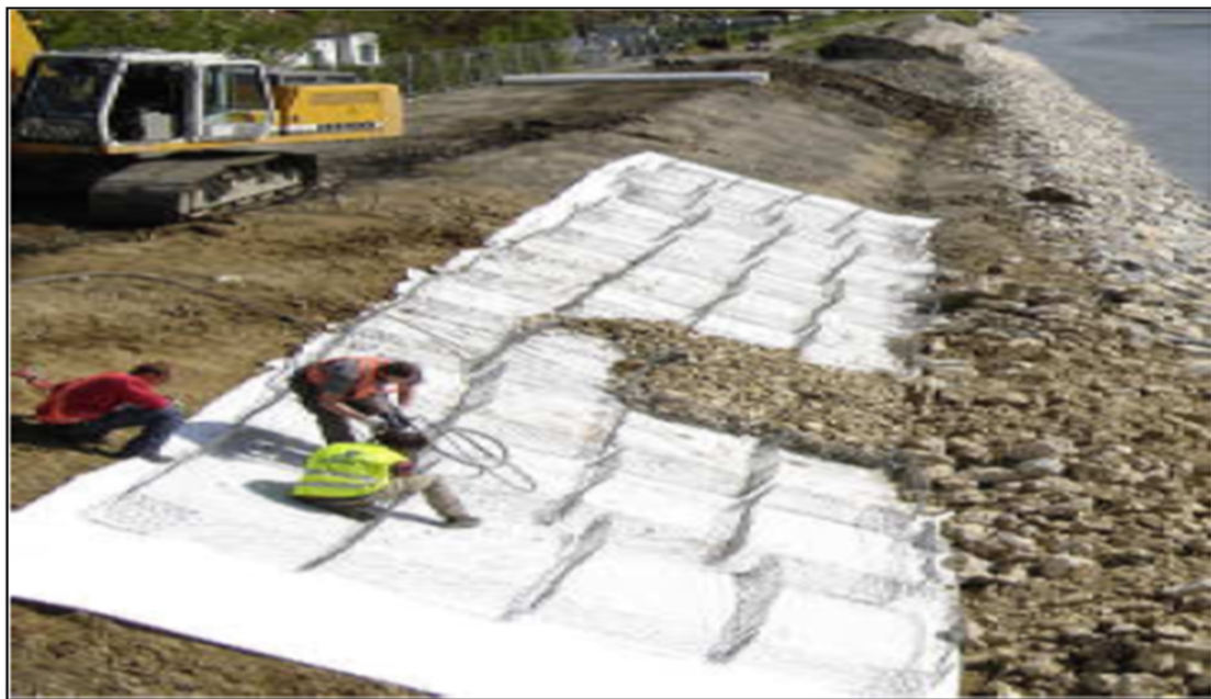
Figure V.5 : Mise en place de Gabion Matelas Galfan [III].
