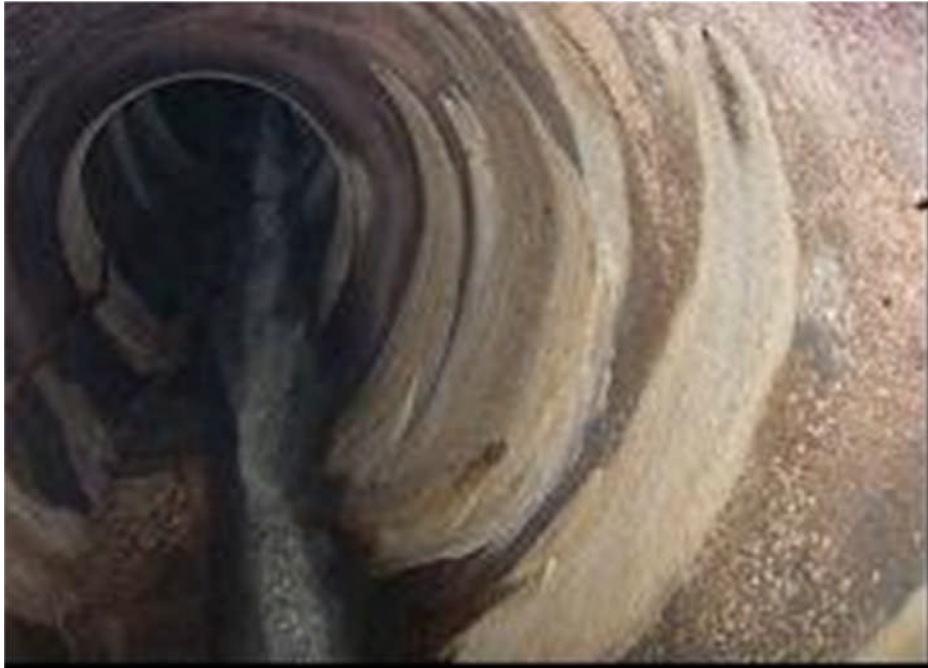
Figure II.5.a : vue dans le collecteur Ravin Blanc.
