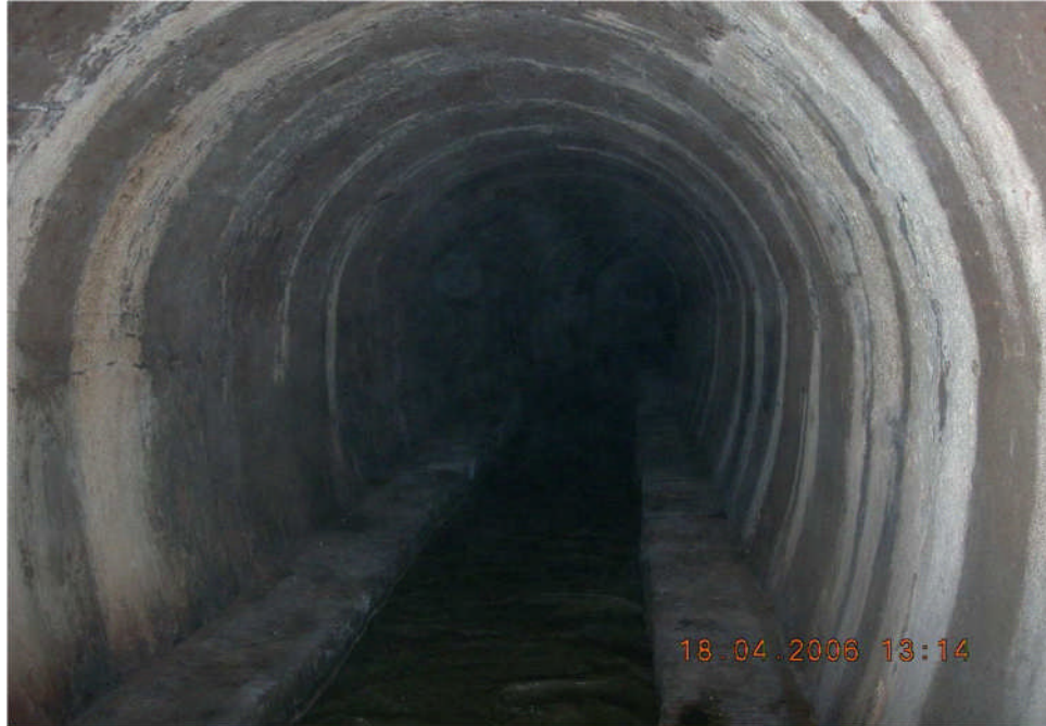
Figure II.6 : vues dans le collecteur Ras El Ain.
