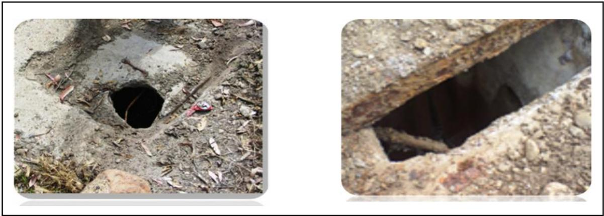
Figure II-3 : Regards existants bétonnés - visite nécessitant la destruction de la dalle due à l'absence des tampons (04/04/2012)
