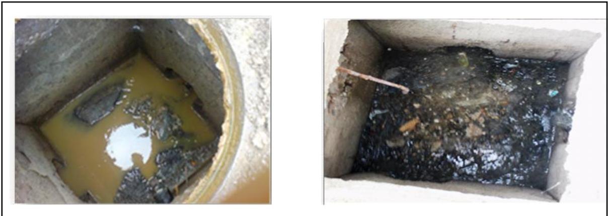
Figure II-2 : Regards existants avec problème de dépôts (04/04/2012)
