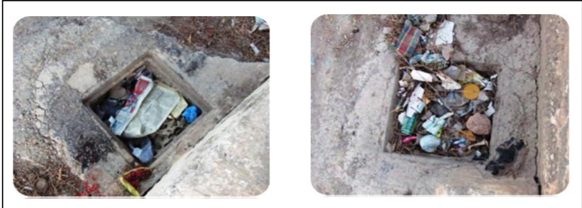
Figure II-5 : Exemple de la bouche d'égout en état dégradé (04/04/2012)
