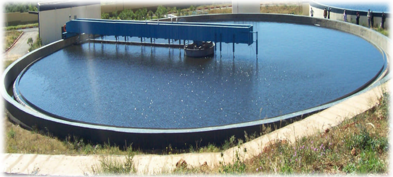
Figure N°13 : décanteur secondaire (clarificateur)
