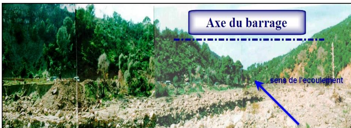
Annexe N°I.03 : vue amont-aval de site de barrage Tarzout.
