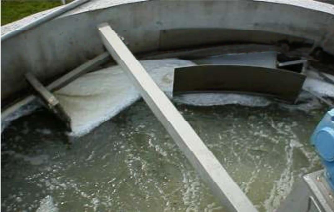
**Figure II.4 :** Photo d'un racleur d'huiles et graisses (racleur de surface).
