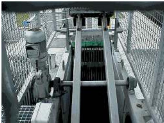
**Figure II.2** : Dégrilleur mécanique.
