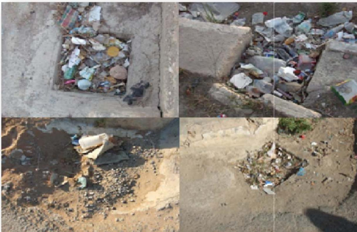
Figure II.8 : Bouches d'égout avec des grilles inexistantes
