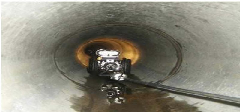
**Figure IX.1** : Photo d'une inspection télévisée, Source
