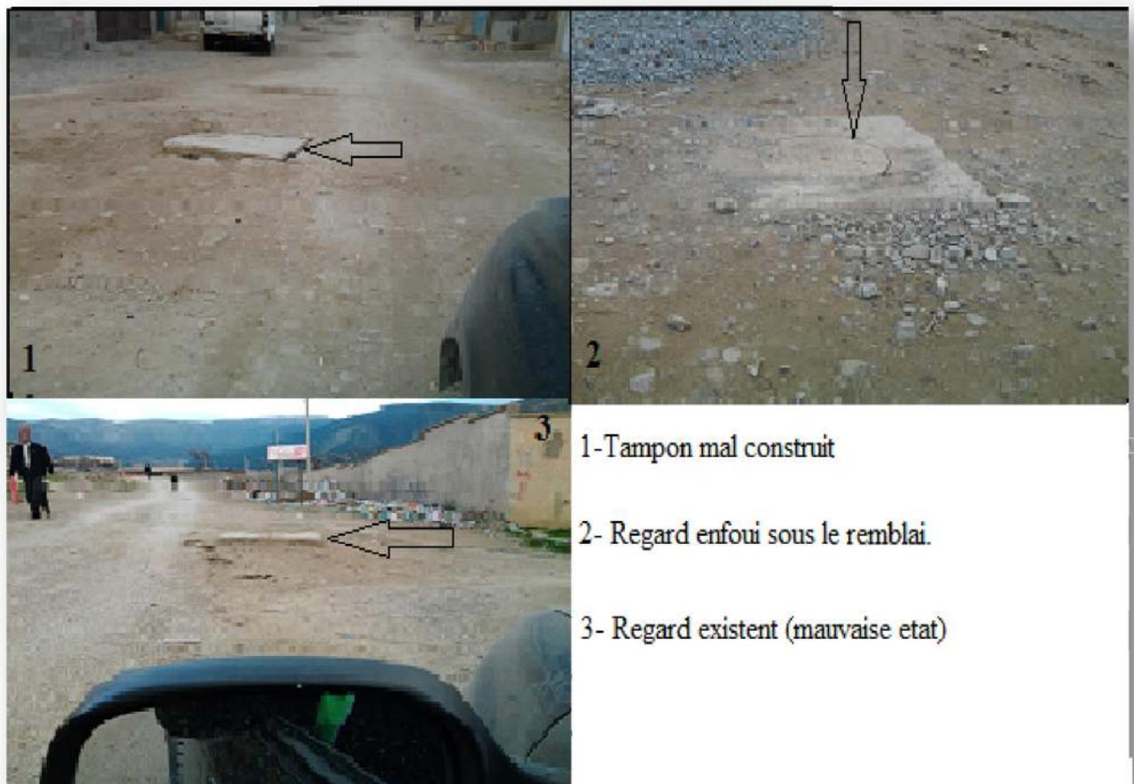
**Figure II.4** : exemple des regards en mauvaise état
