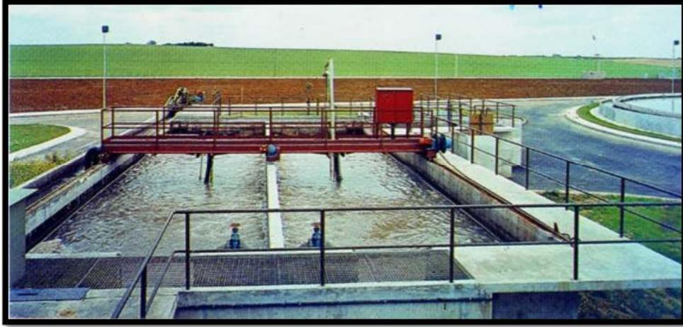
**figure III.5.** Dessableur rectangulaire aéré.[Station d'épuration de baraki]
