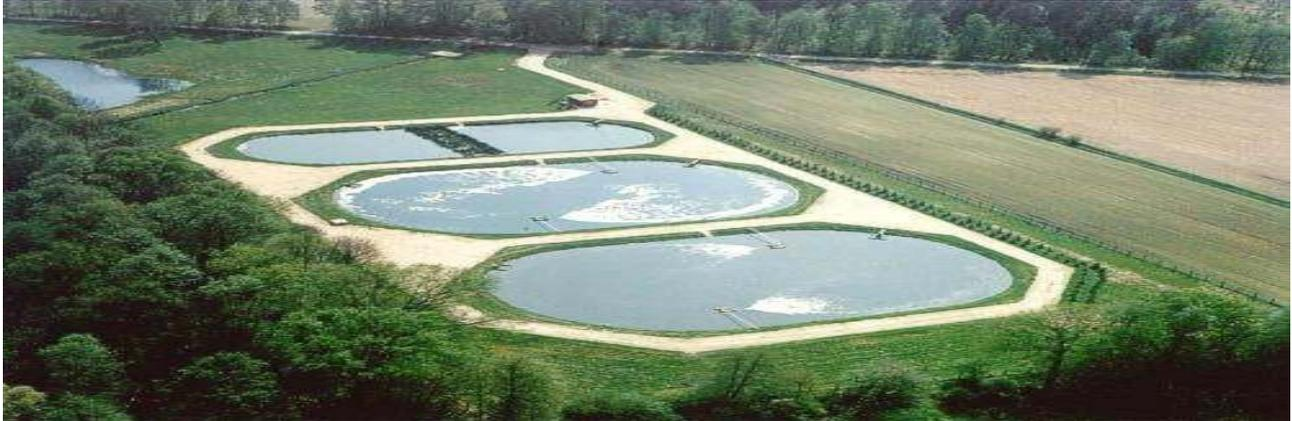
**Fig. n°III.4: système d'épuration par lagunes aérées**
