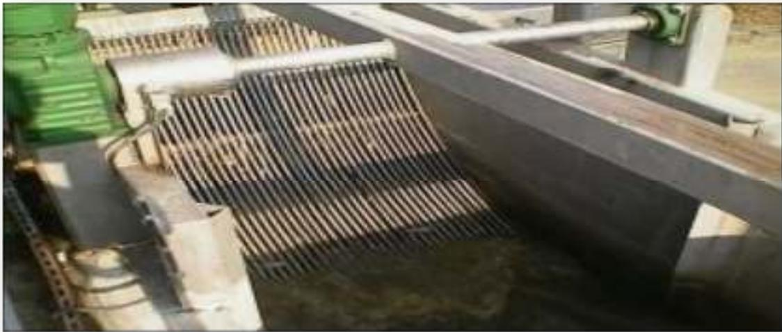
**Figure IV.3 :** Grille mécanique courbée (Source [www.Wikipedia.com](http://www.Wikipedia.com)).
