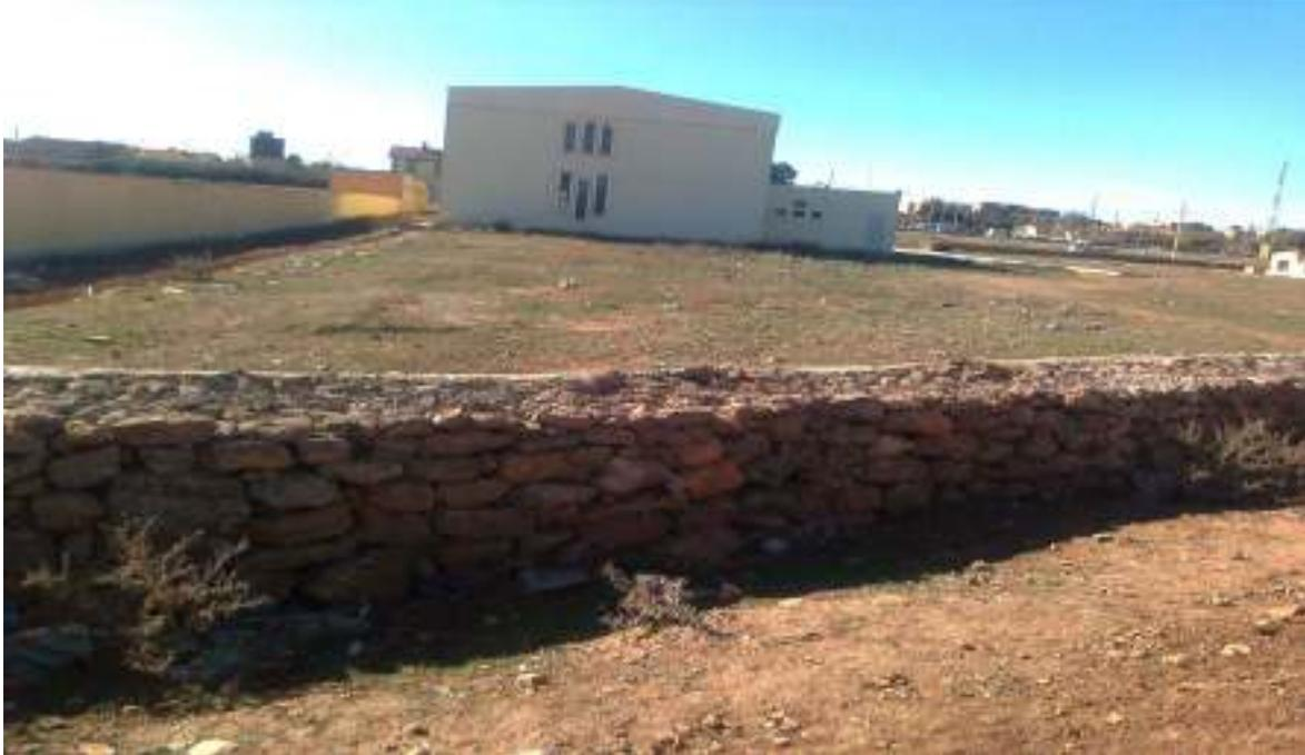
**Figure.II.4.**Protection du CEM par un mur en gabionnage
