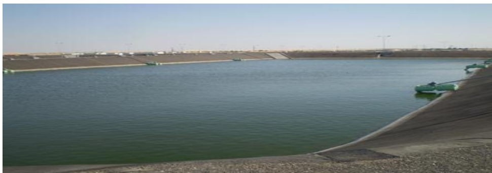
Figure IV 2 : Lagune d'aération en service
