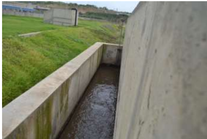
Figure IV.3 : Recirculation des boues
