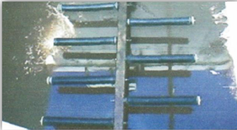
Figure. IV.4 : Photo d'un diffuseur poreux
