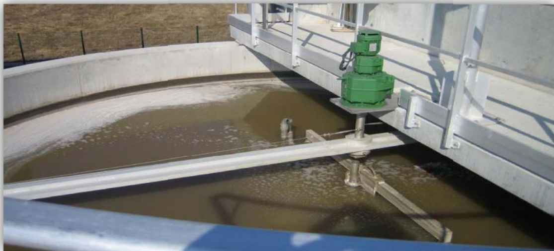
Figure. III.3 : Photo d'un racleur des graisses.
