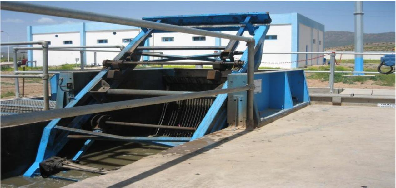
**Figure I.2. Le Dégrilleur**
