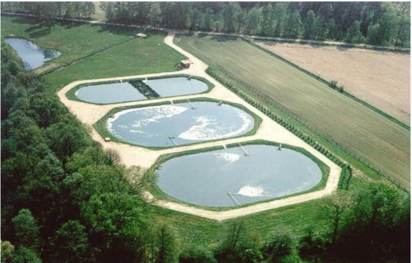
**Figure III.6 :** système d'épuration par lagunes aérées
