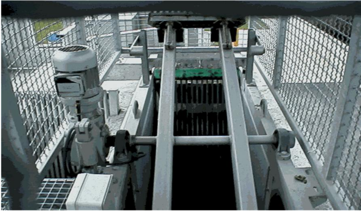
Figure II.1 : Ouvrage de dégrillage
