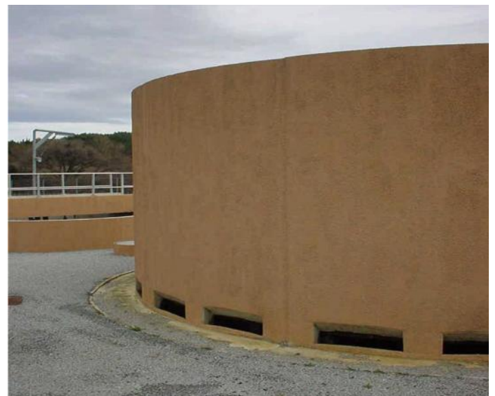
Figure II.8 : Ouïes d'aération du lit bactérien
