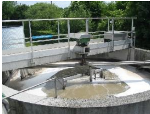
Figure III-6 : déssableur-dégraisseur combiné
