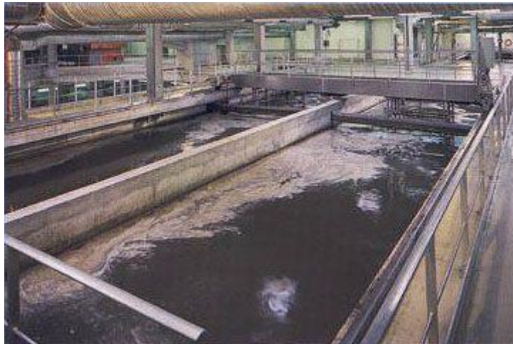
Figure III-7 : Dégrossisseur-déshableur rectangulaire
