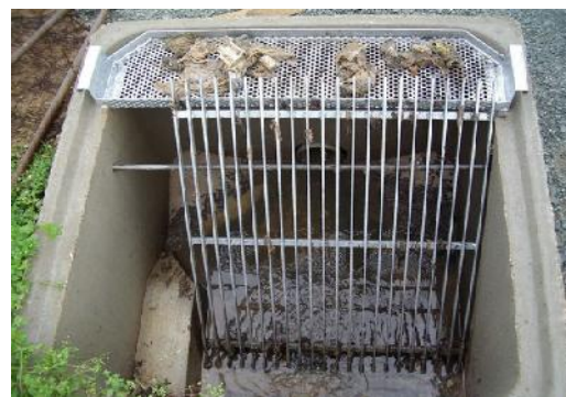
Figure III-4 : Grille mécanique
