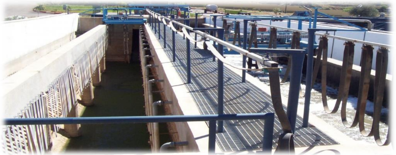
Fig. n°V.4 :dessableur- déshuileur de la STEP de TLEMCEN
