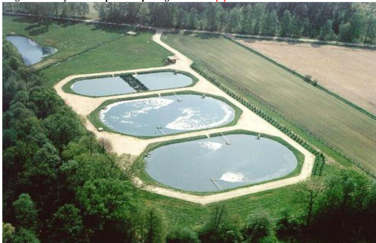
Fig. n° III.6 : système d'épuration par lagunes aérées [6]
