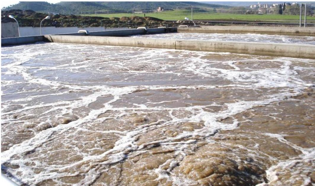
**Figure III.3 :** Bassin d'aération (plein) avec aérateurs de fond
