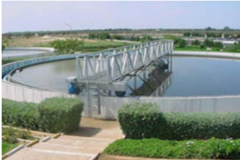
**Figure III.6:** Décanteur secondaire
