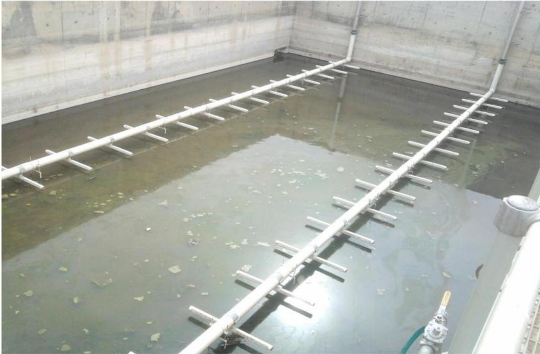
**Figure III.2 :** Bassin d'aération (vide) avec aérateurs de fond
