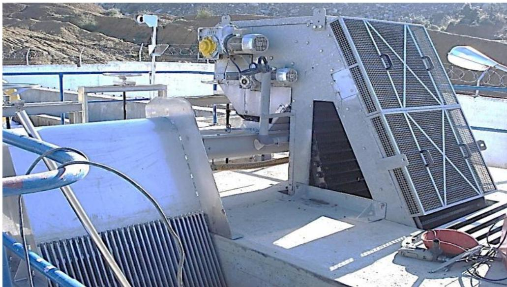
**Figure II.2 :** Grille mécanique.
