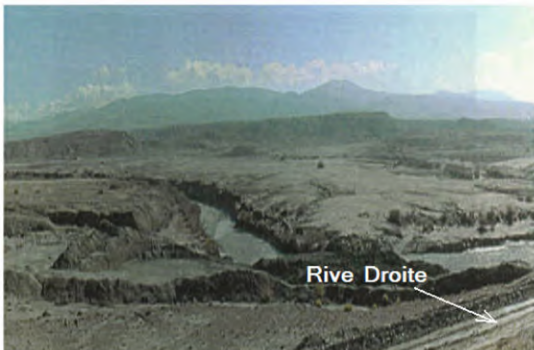
Photo N°06 : Vue générale du site de barrage depuis la rive droite (En direction de sud)
