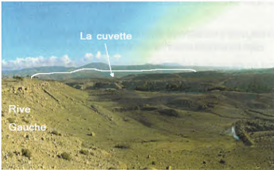
Photo N°01 : La cuvette de barrage (vue depuis la rive droite)
