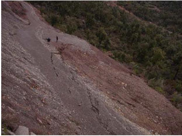
**Photo 2.1** : Fissures longitudinales dans la routé affecté par le glissement
