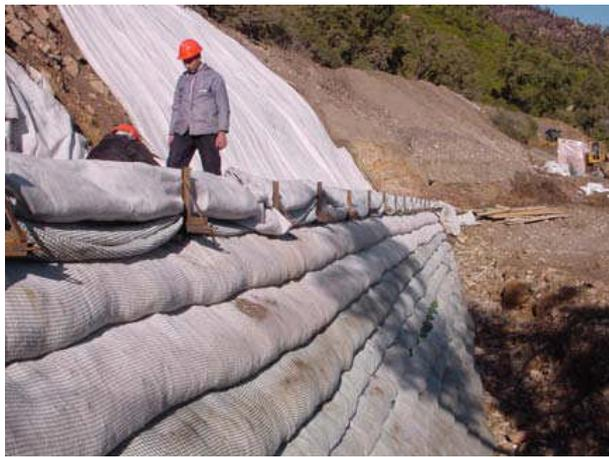
**Photo 2.2** : Construction de l'ouvrage par couches
