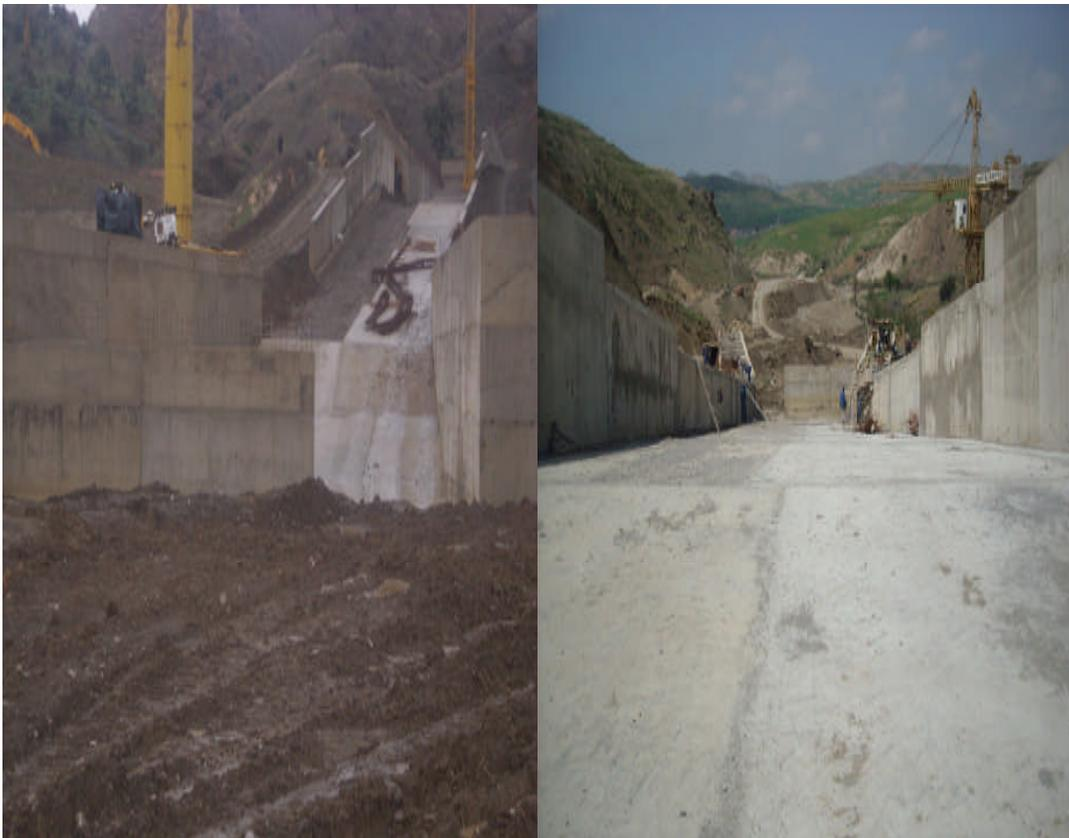
**Photo I.4. Évacuateur de crue au cours de réalisation.**
