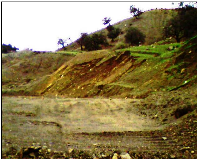
Photo 2.9 : glissement de la rive gauche du barrage de Tamellahet
