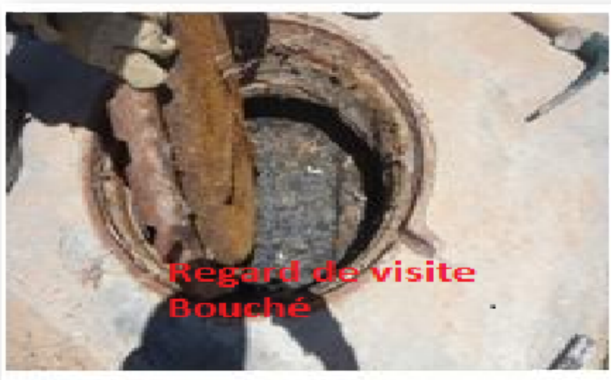
Photo IV.3 : Regard à sec et rempli d'objets solides
