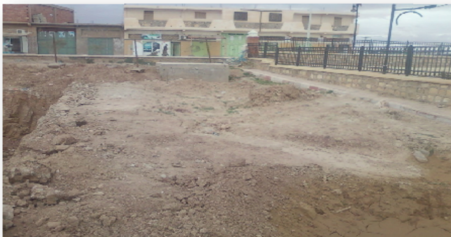
Photo IV.2: les travaux de génie civil au voisinage au réseau d'assainissement
