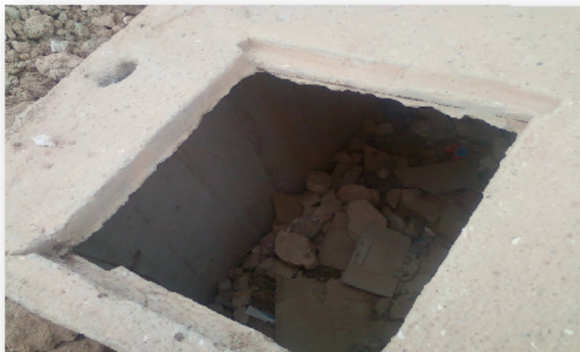
Photo IV.3 : Regard à sec et rempli d'objets solides
