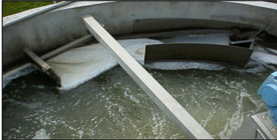
Figure III.6 : Déshuilage par écumage des graisses.
