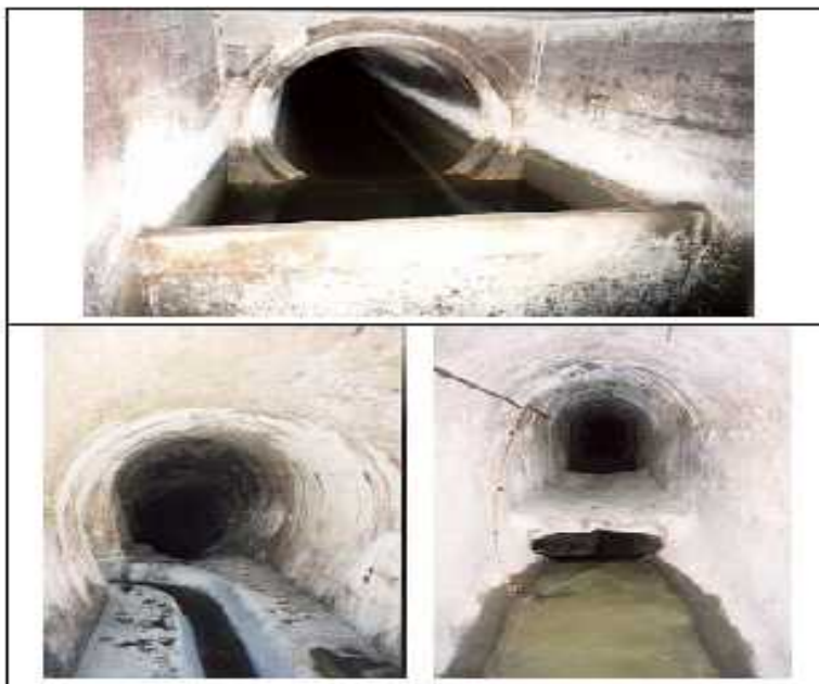
Figure N° (VII -10): Exemples de déversoir frontal
