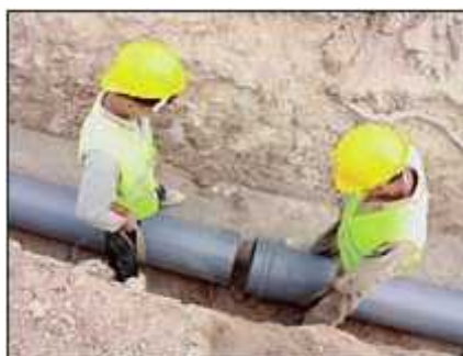
Figure N° (VII -1) : Assemblage par collage à froid
