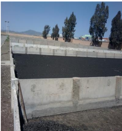
Figure VI.4: Lits de séchage de L'ancienne SETP de ville de Bordj Bou Arreridj
