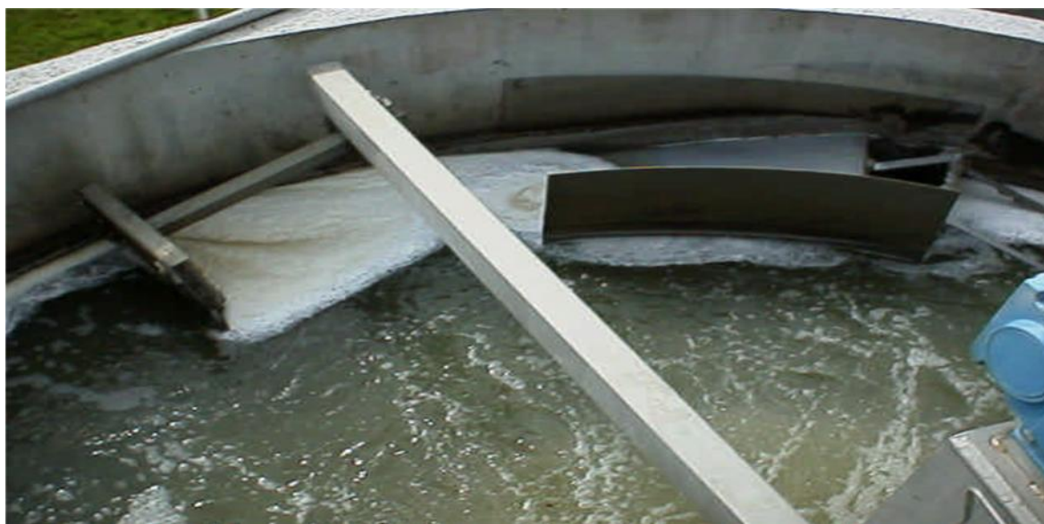
Figure III.8: Racleur des graisses d'un déssableur- dégraisseur
