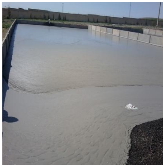
Figure VI.4: Lits de séchage de L'ancienne SETP de ville de Bordj Bou Arreridj
