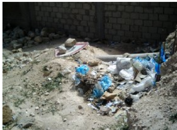
Photo II.17: Raccordement de l'assainissement des habitations
