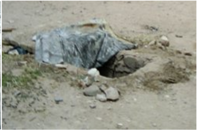
Photo II.6: Vue générale sur la situation d'assainissement de la cité 1 Novembre.
