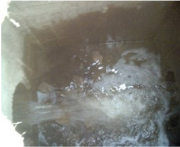
Photo II.9: Vue intérieure d'un regard de visite
