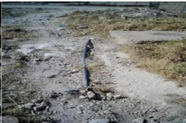
Photo II.18: Vue sur un regard d'assainissement
