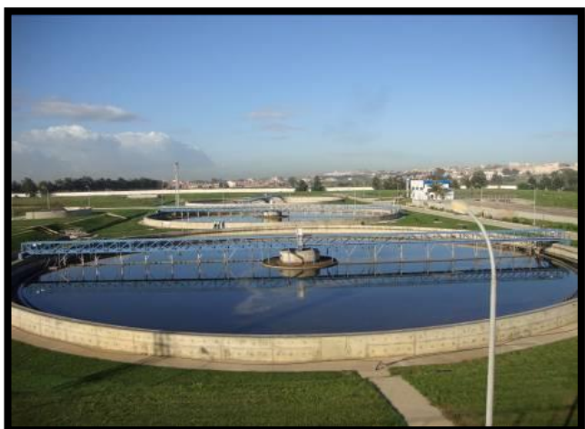
Figure 8 : Clarificateur
