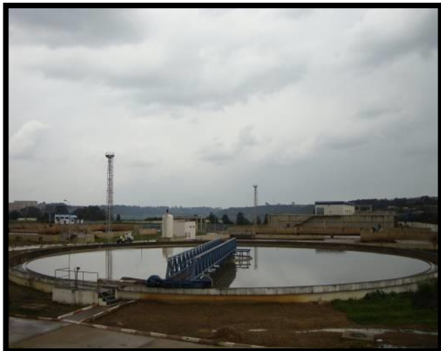
Figure 6 : Décanteur primaire
