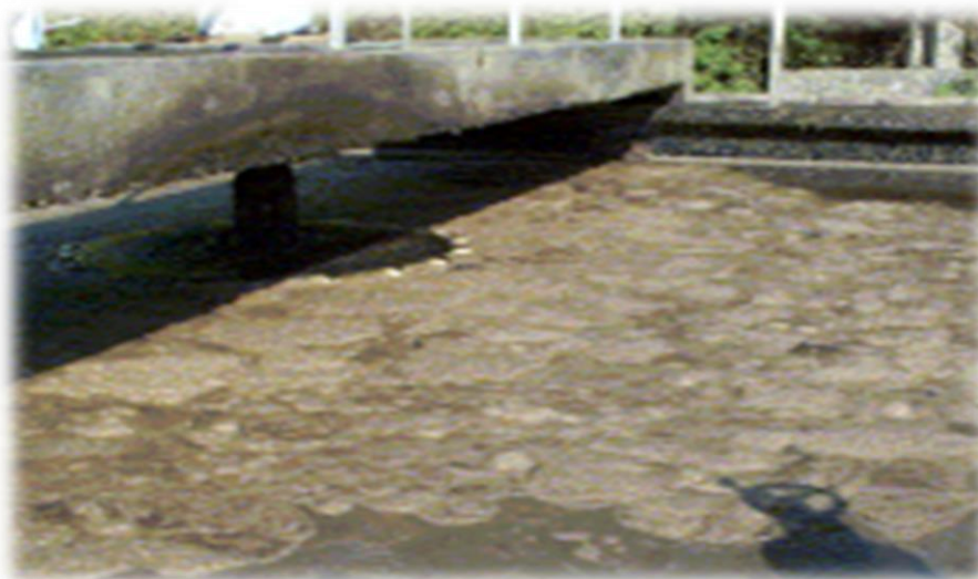
Figure IV.5 : Densité excessive des boues dans le bassin
