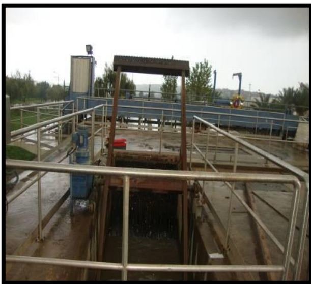
Figure 3 : Dégrilleur
