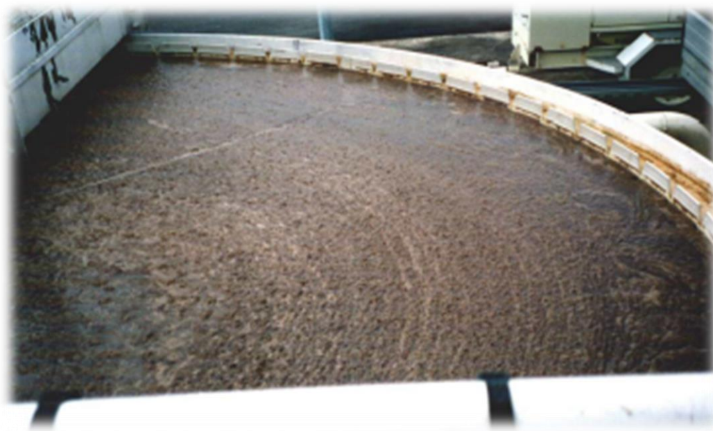
Figure IV.4 : Mousses stables dans un décanteur
