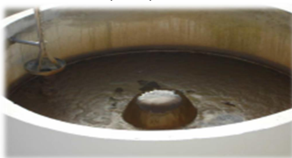
Figure IV.2 : La fermentation des boues et conséquences
