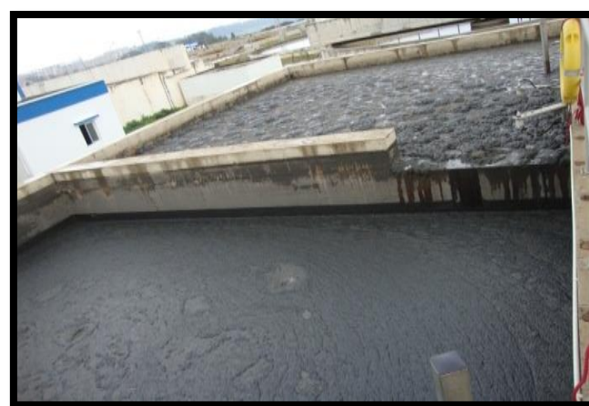
Figure 11 : Bâche de stockage des boues
