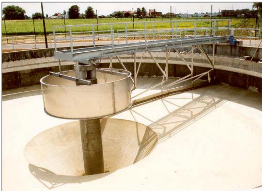
Figure III.12: Décanteur circulaire à raclage mécanique.
