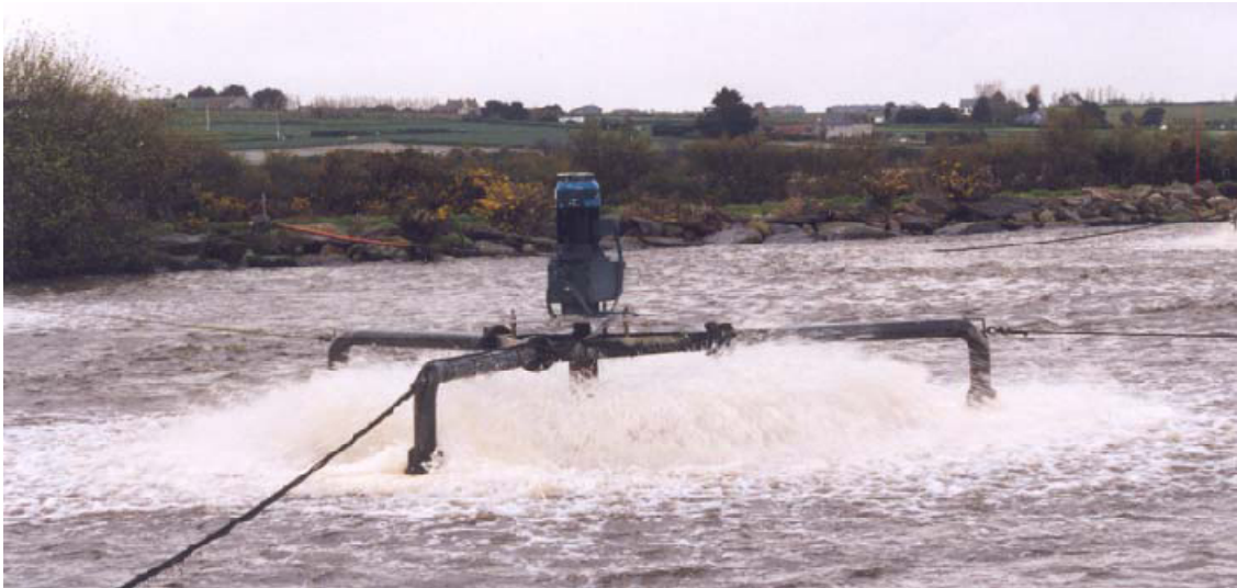
Figure III.21 : lagunage aéré.
