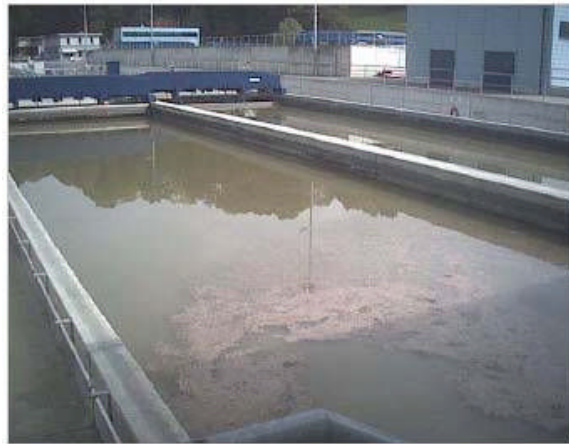
Figure III.10 : décanteur primaire.
