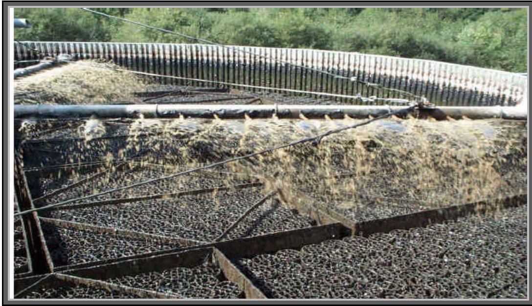
Photo N° 03: Alimentation du lit bactérien (garnissage plastique)
