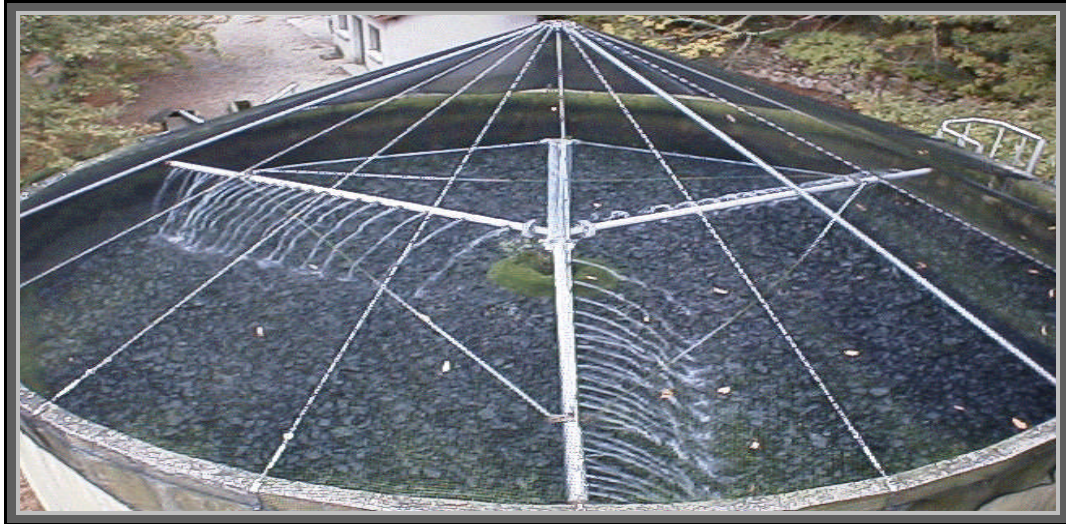
Photo N° 02: Lit bactérien à remplissage traditionnel (Joseph. P et Al, 2002) .
