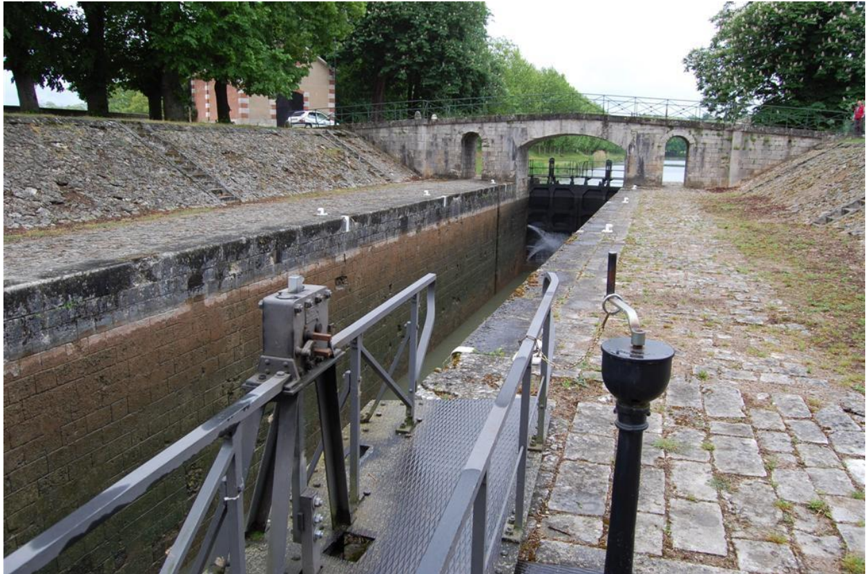
Figure III.11 : canal en maçonnerie
