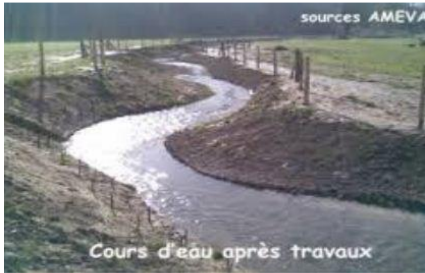
Figure III.4: Recalibrage d'un cours d'eau
