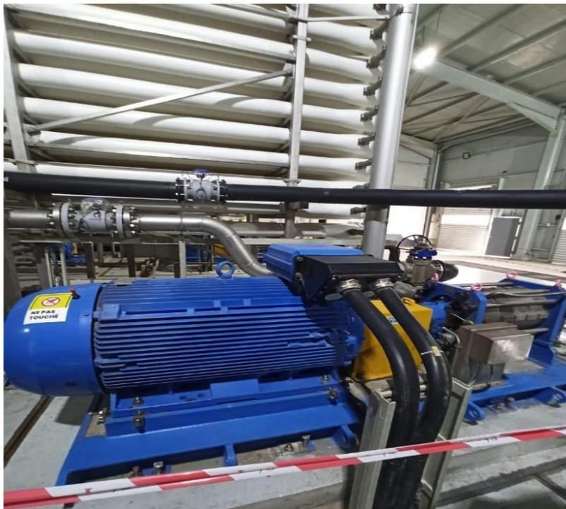
Figure IV.18 : Pompe à haute pression
