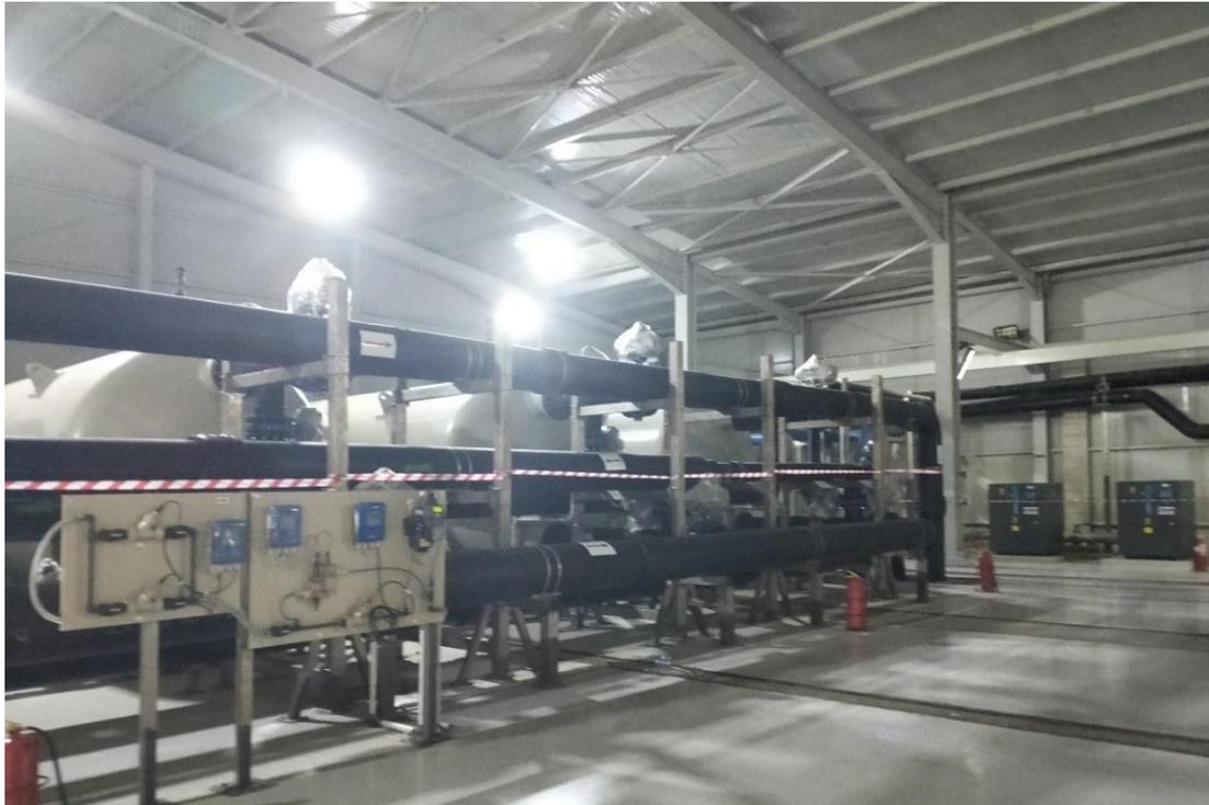
Figure IV.15: les filtres à sable sous pression à double couche
