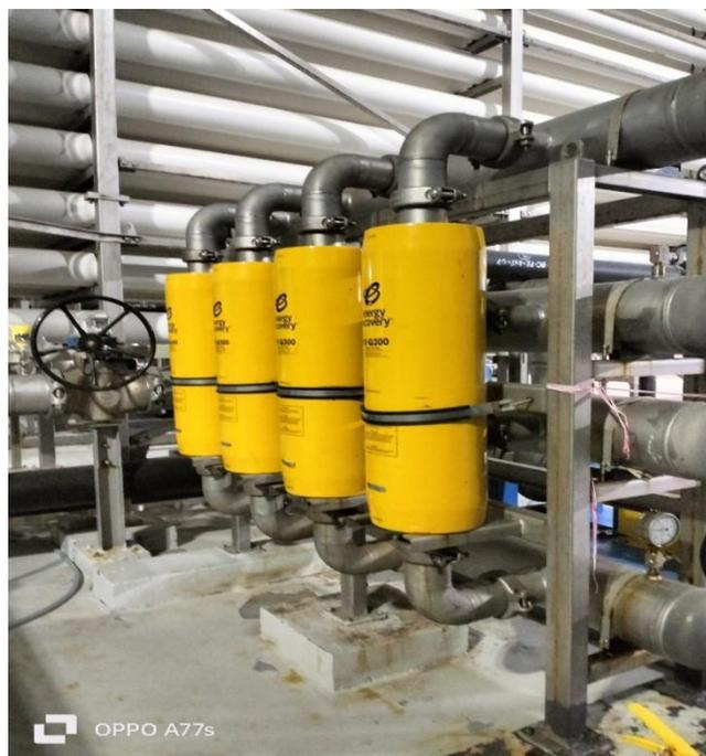
**Figure IV.20 :** Dispositifs de récupération d'énergie (ERD)
