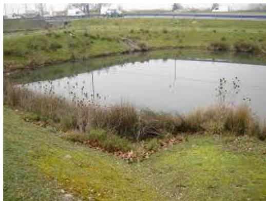
**Figure IV.19 : Bassin de rétention par infiltration. Source (hmf.ensee.ht.fr)**
