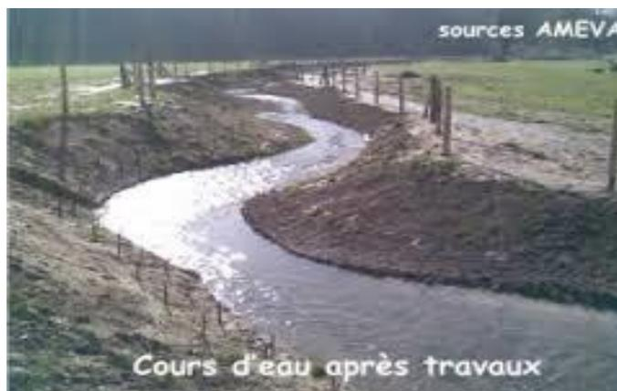
Figure IV.4 : reprofilage d'un cours d'eau.
