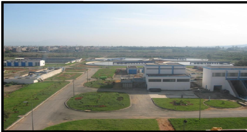
Figure VII.1-Station d'épuration de de Baraki
