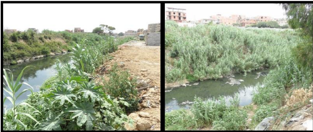
Figure IV.3 : Etat du tronçon 2
