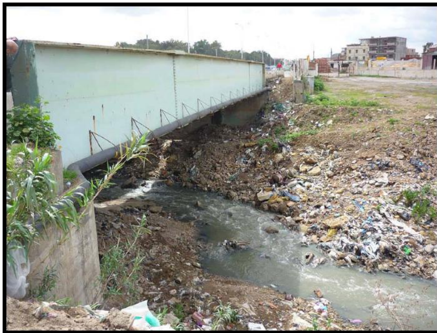
Figure annexe 12 : Pont la RN 24 + tramway PK 1650
