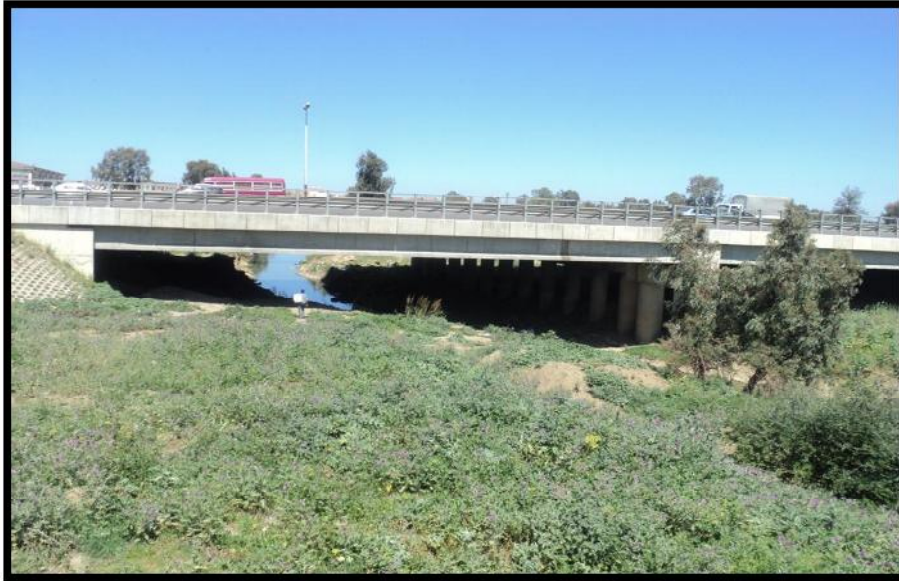
Figure annexe 9 : Pont de l'autoroute PK 9100
