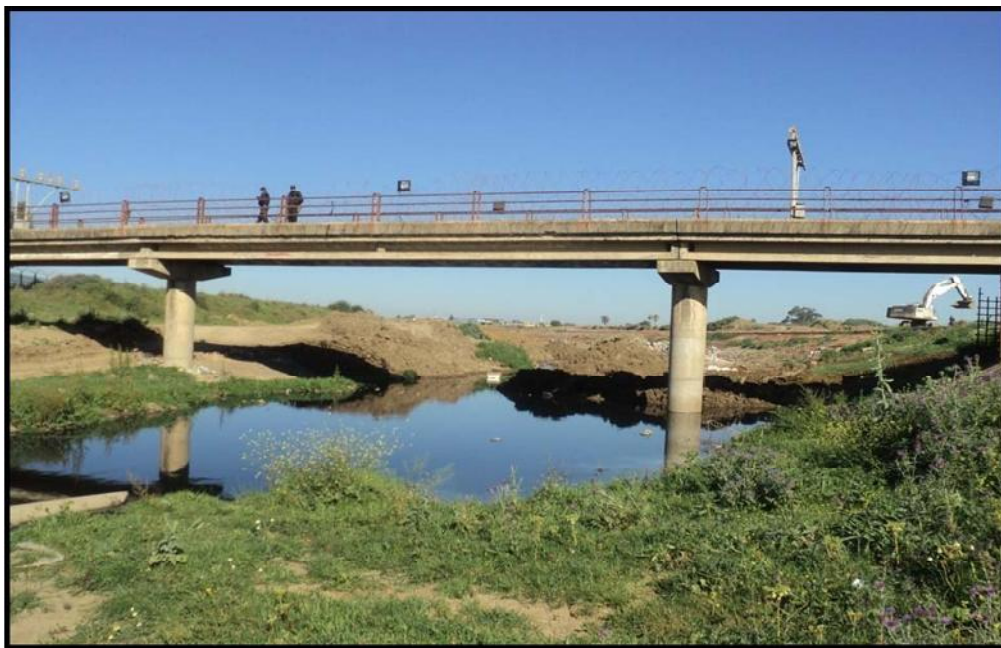
Figure annexe 8 : Pont de l'aéroport Pk 10500
