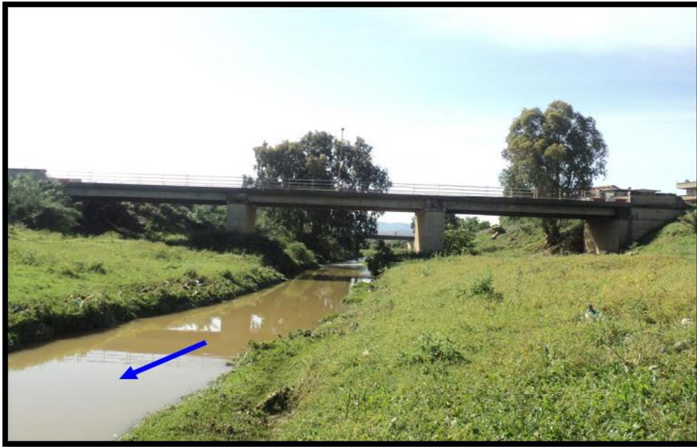
Figure annexe 7 : Pont Hammadi (cw 149) PK 14400
