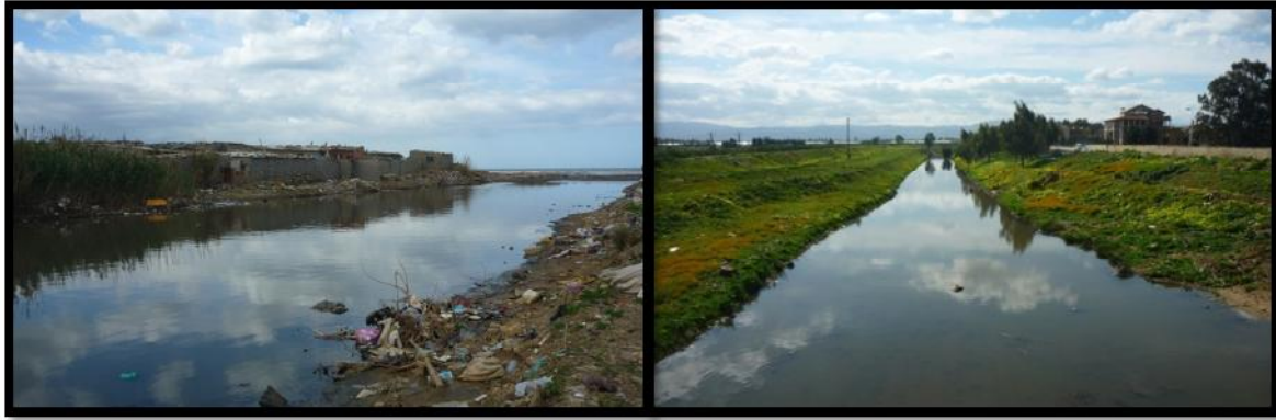
Figure IV.2 : Etat du tronçon 1
