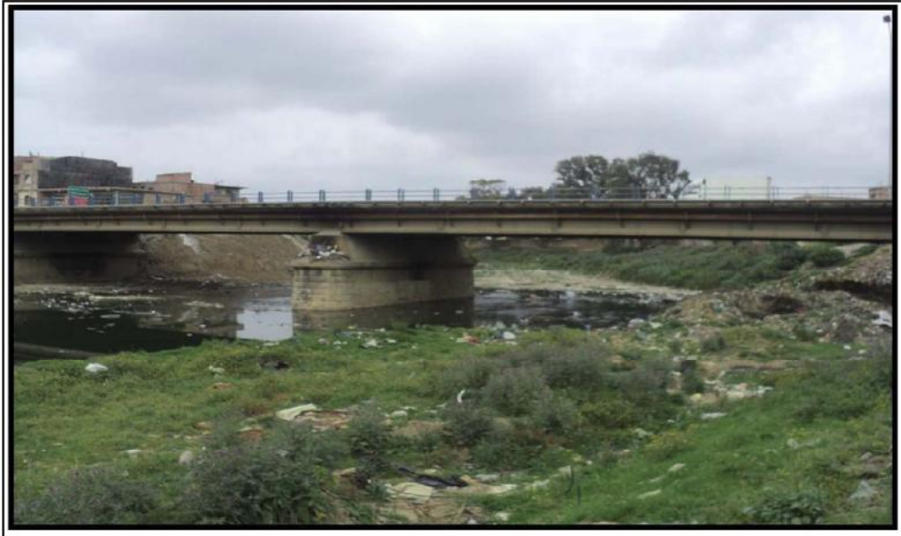
Figure annexe 11 : Pont d'El Hamiz PK 7200
