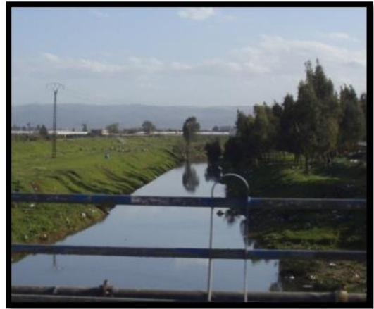
Figure IV.5 : Etat du tronçon 4
