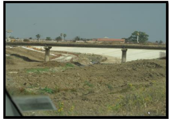
Figure IV.6 : Etat du tronçon 5
