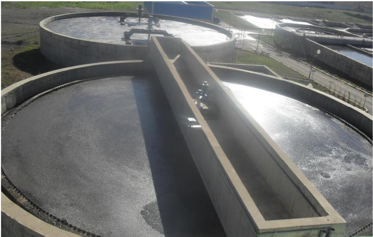
**Figure III.3:** clarificateur de la STEP de BOUIRA.
