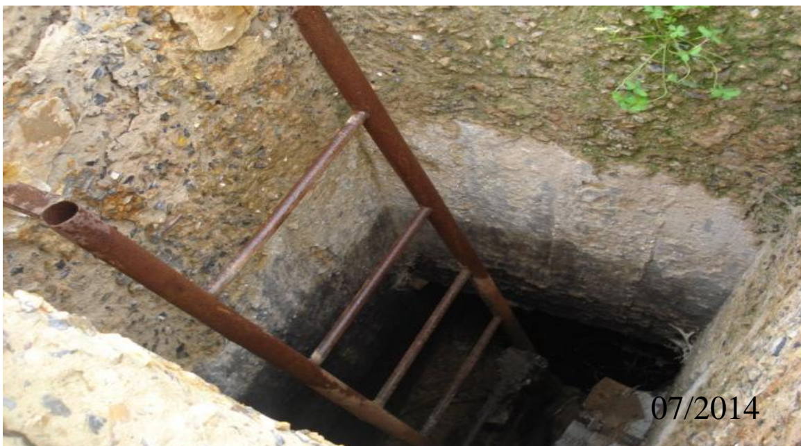
Figure II.4 rejet N°03 bassin de décantation
