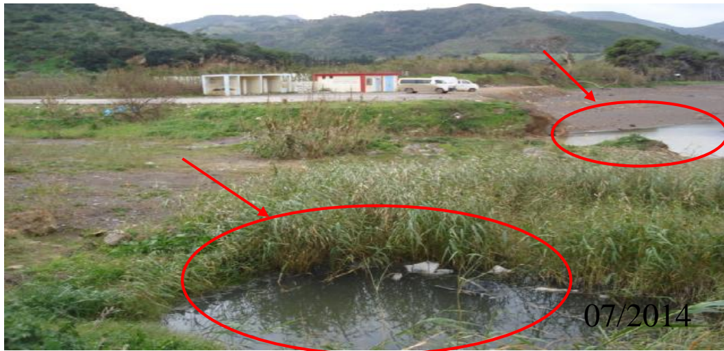
Figure II.5 rejet N°06 et N°07 bassin de décantation
