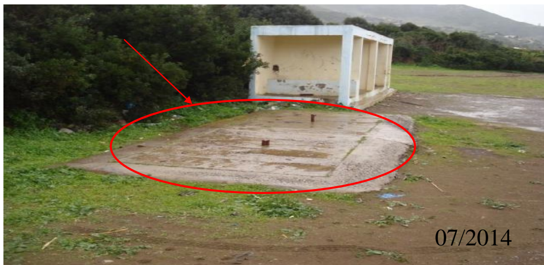
Figure II.6 rejet N°08 bassin de décantation
