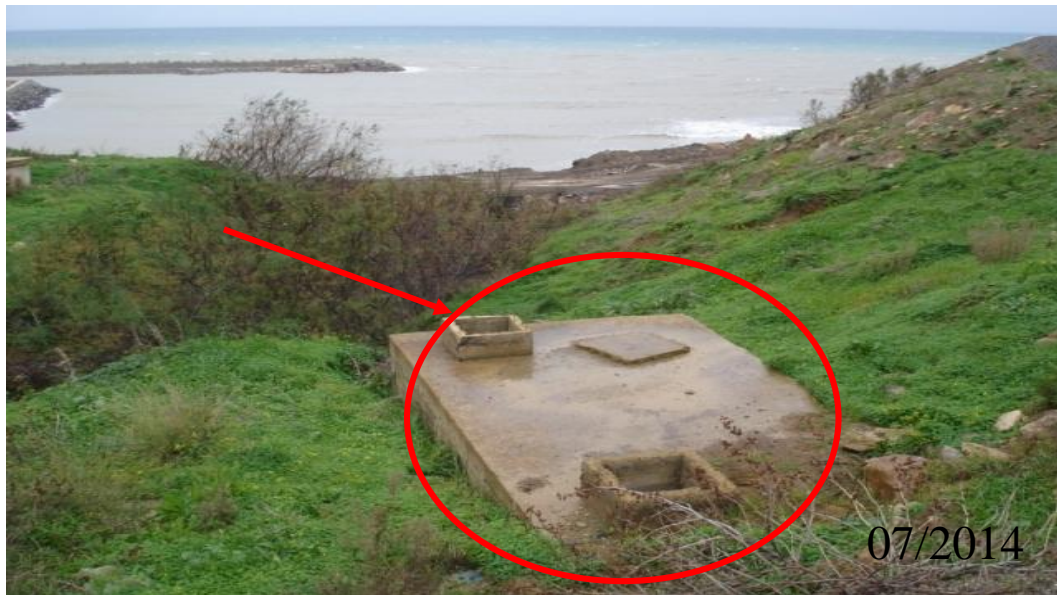
Figure II.1 rejet N°01 bassin de décantation
