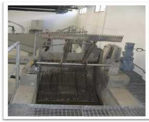
**Figure II.3:** la grille mécanique
