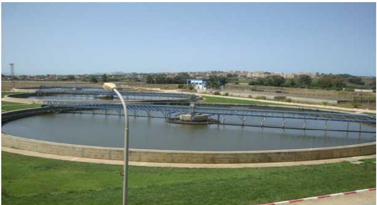
**Figure III.4.**décanteur secondaire (photo pris de la STEP de REGHAIA).
