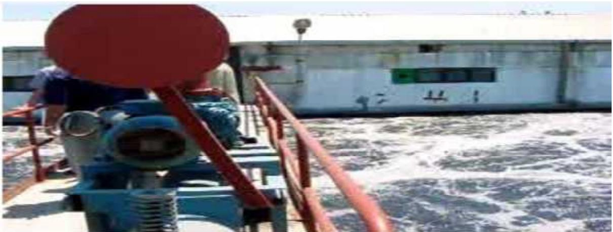
**Figure III.3.** Bassin d'aération par diffuseur d'air (photo pris de la STEP de REGHAIA).
