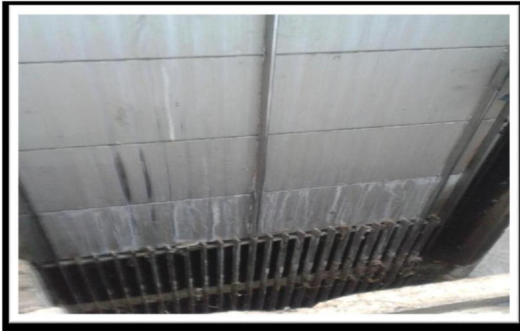
**Figure VI.2 :** dégrilleur grossier automatique en arrêt.
