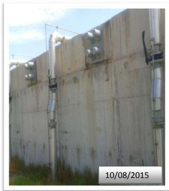
**Figure I.8 :** zone de recirculation des boues. **Figure I.9 :** conduites d'injection d'O<sub>2</sub>.
