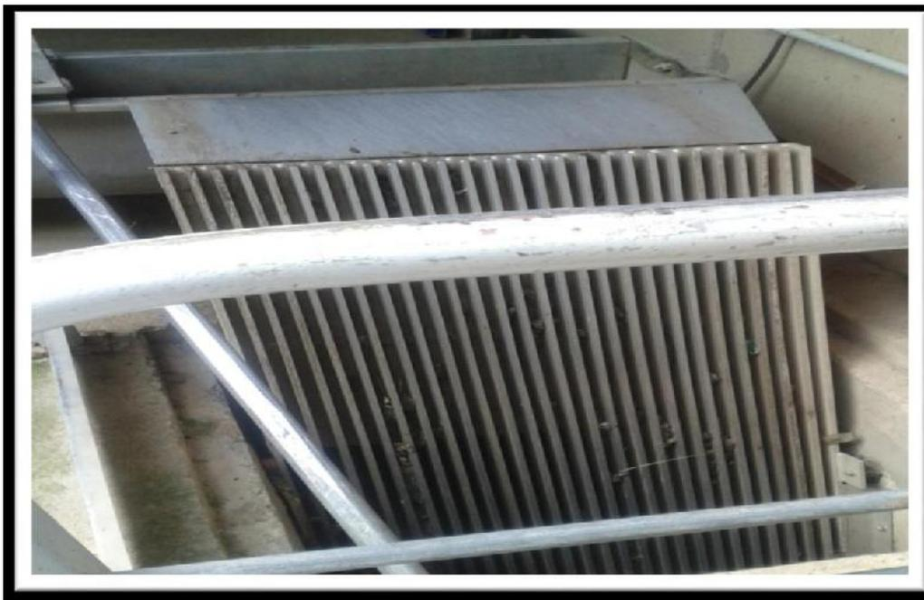
**Figure VI.3 :** dégrilleur moyen automatique en arrêt.
