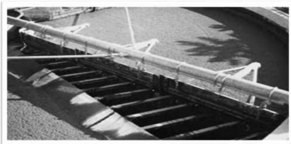
**Figure III.3.** : Epaisseur à flottation
