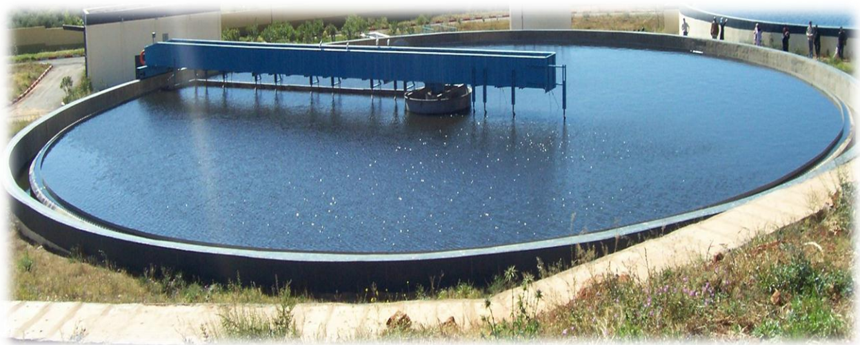
Figure. IV.4 : décanteur secondaire (clarificateur)
