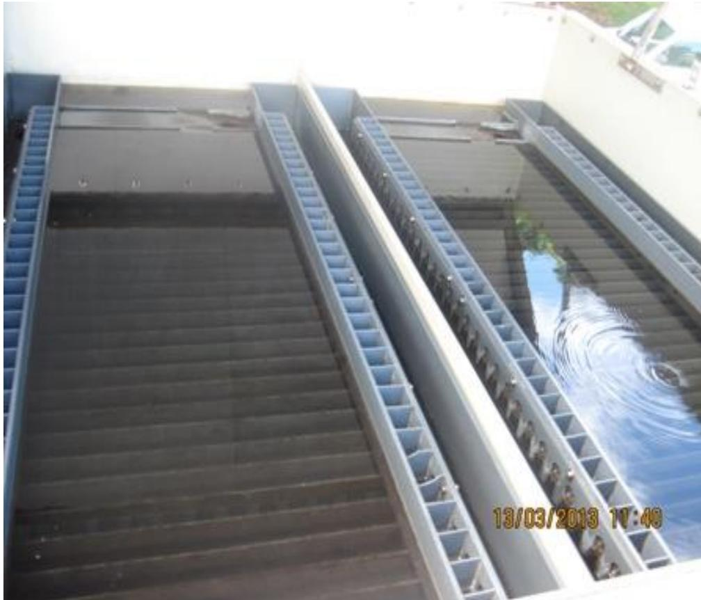
**Figure II.5 :** Décanteur lamellaire. (Source : ecolycee.e-monsite.com)
