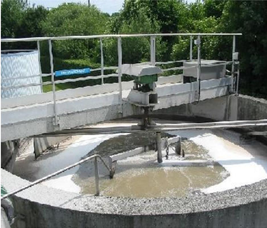
**Figure II.4 :** Photo d'un racleur d'huiles et graisses (racleur de surface).
