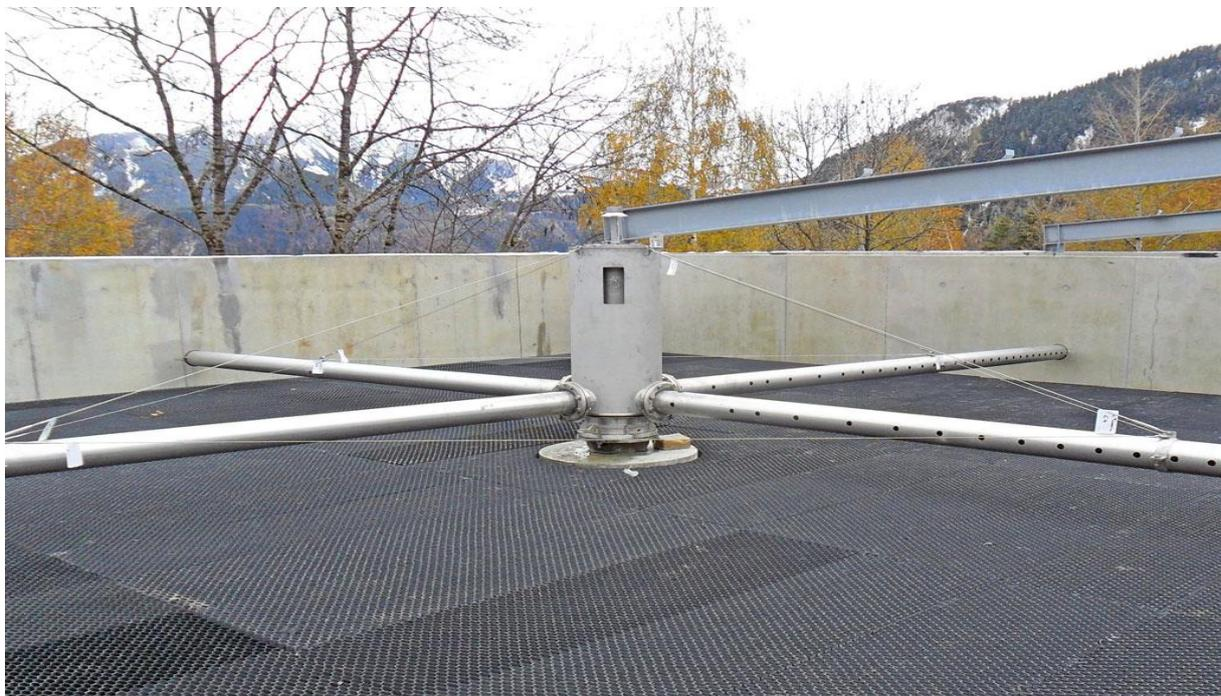
Figure II.18 : lit bactérien avec sprinkler. (Source : www.ricom-web.com)
