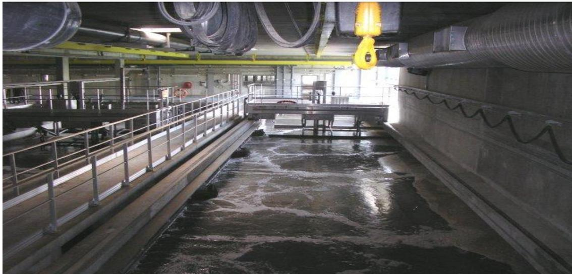
**Figure II.3 :** Dessablage, déshuilage et dégraissage dans un seul ouvrage
