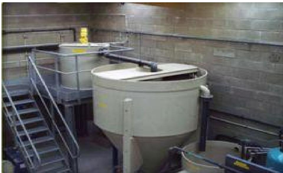
**Figure II.6 :** Décanteur cylindro-conique (source : www.actibio.fr )
